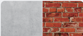
Mur en béton
